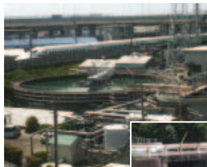
排水処理施設
