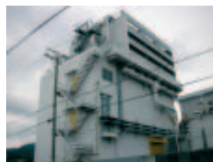
運転を休止した 自家発電設備の外観
