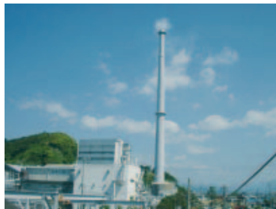
以前運転していた自家発電施設
