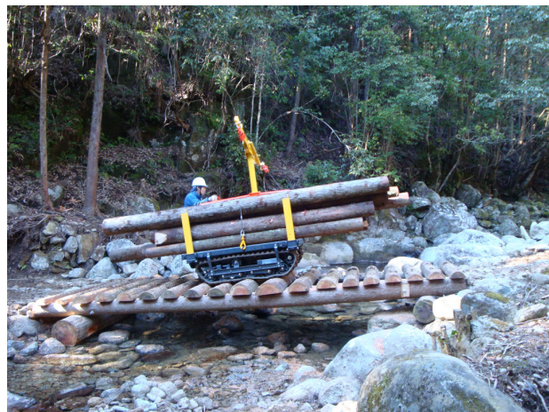
林内作業車による間伐材の搬出の様子 (三重県南牟婁郡紀宝町)
