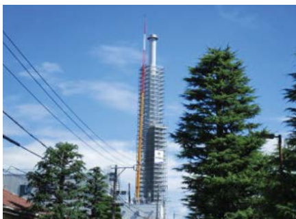
撤去のため足場が組まれた煙突
