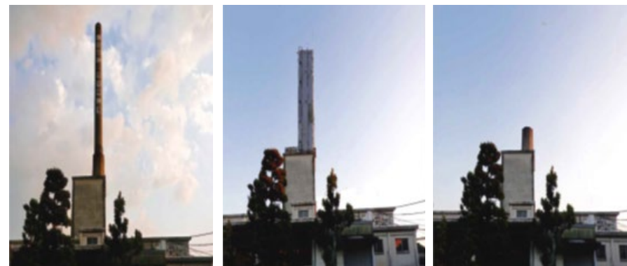
煙突 解体前と後
