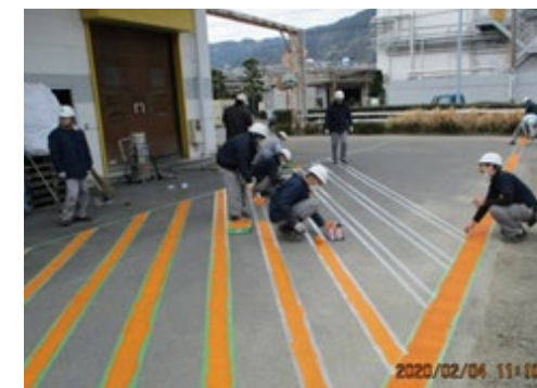
作業エリアの塗装作業
