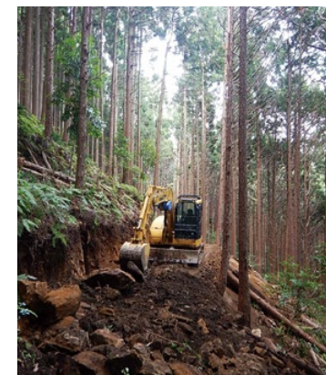
作業道の開設
