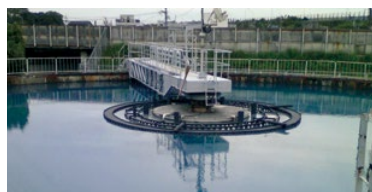
排水処理施設
