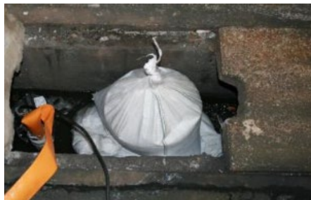
緊急時対応訓練：側溝に土囊を入れ薬品をせき止め、ポンプにて回収
