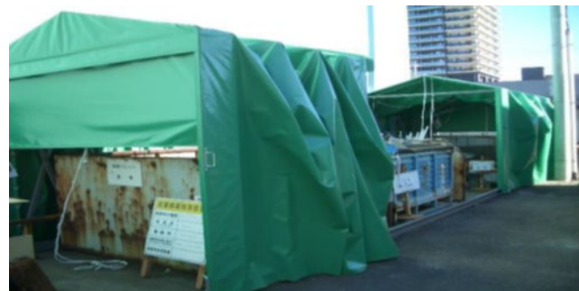
廃棄物置き場の土壌汚染対策（簡易テントの設置）
