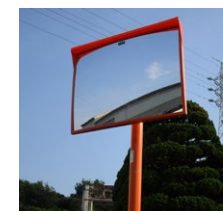
新設されたカーブミラー
