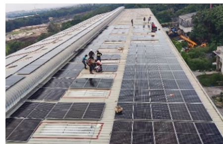
太陽光パネルの設置工事の様子
