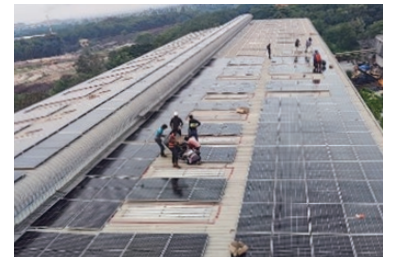
太陽光パネルの設置工事の様子
