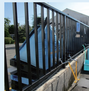
設置した「フジコン」
