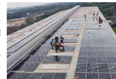
太陽光パネルの設置工事の様子
