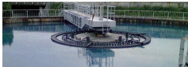
排水処理施設
