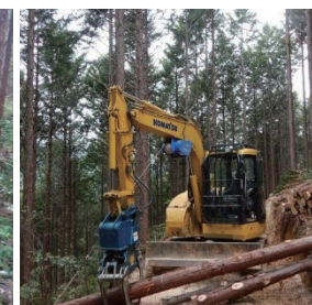
搬出間伐作業状況
