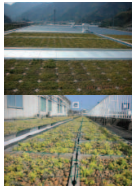
屋上緑化風景
