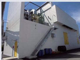
静岡事業所に導入された CO 2 ジェネレーション設備
